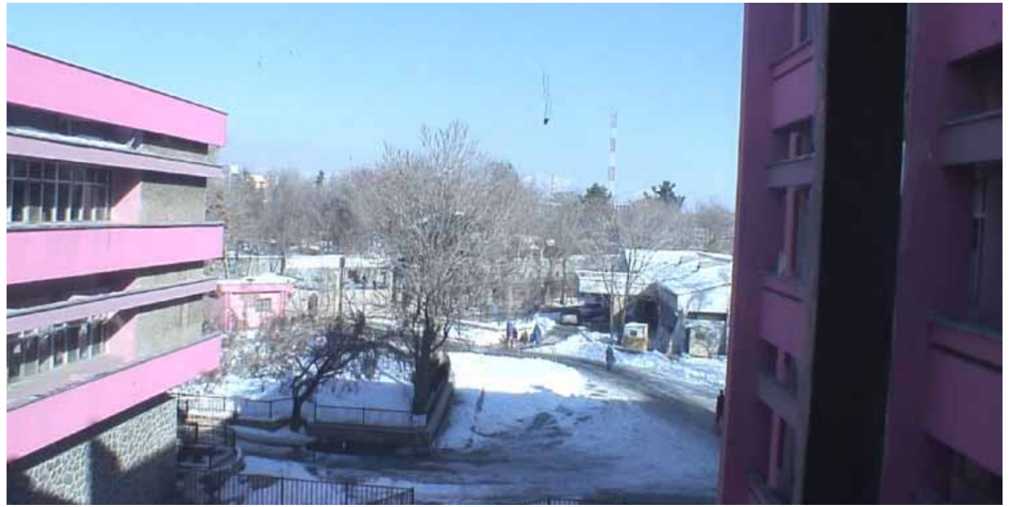
病棟の外壁だけが塗り替えられていく
